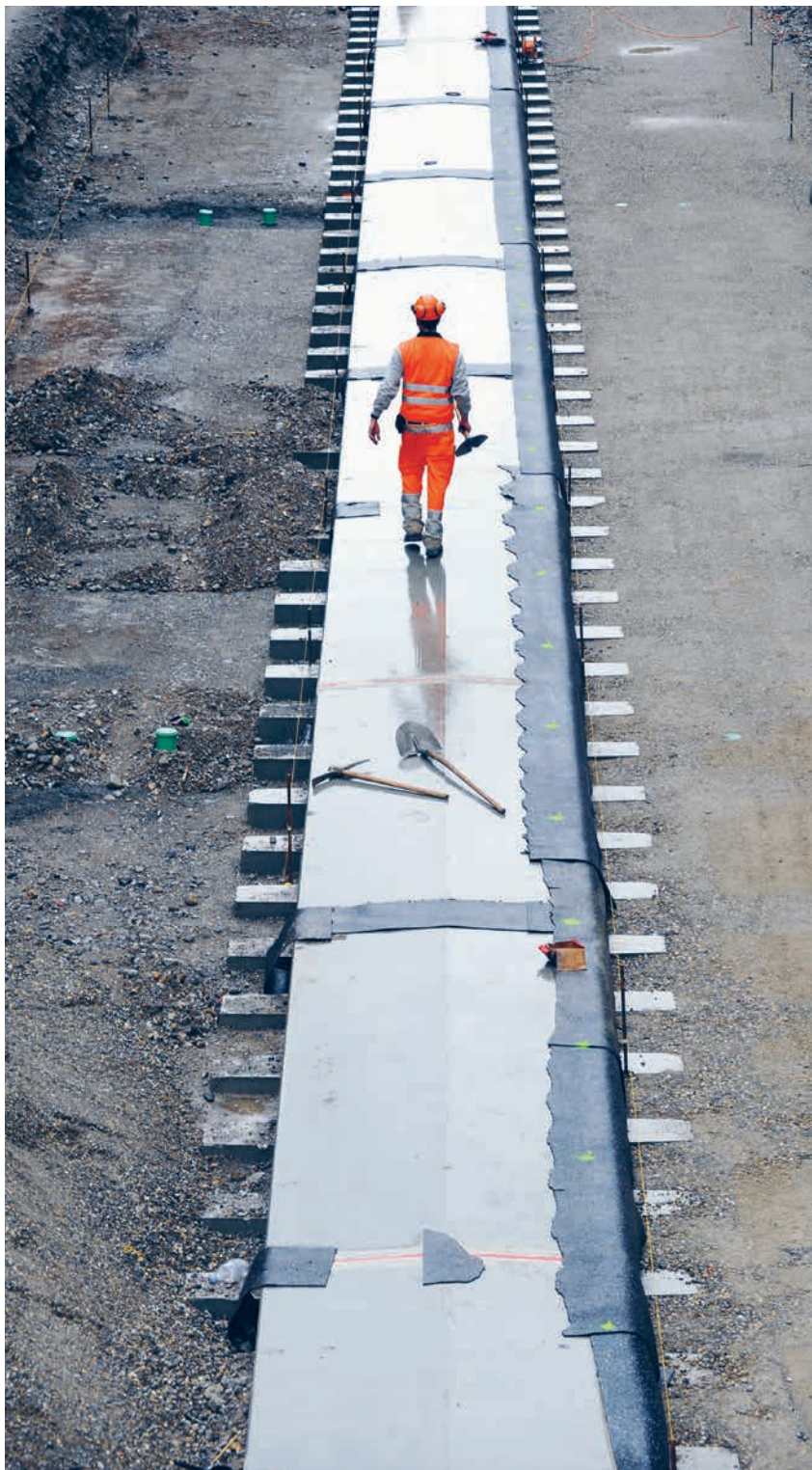
Bildthema 2.14 ist der Gleisbau. Hansueli Trachsel hat in Bern die Erneuerung der Tramgleise fotografiert. Arbeiter in Warnfarben und Helm auf der langen Geraden. Sie legen die Schienen fürs tägliche Vorwärtkommen. Ihre Anstrengungen bahnen uns Menschen den Weg ans Ziel.
